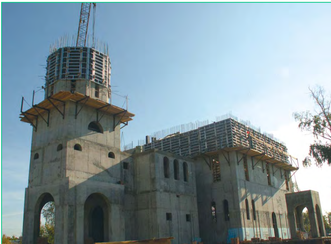
Возведение храма “Ильи Пророка” в г. Апрелевка Московской обл.
