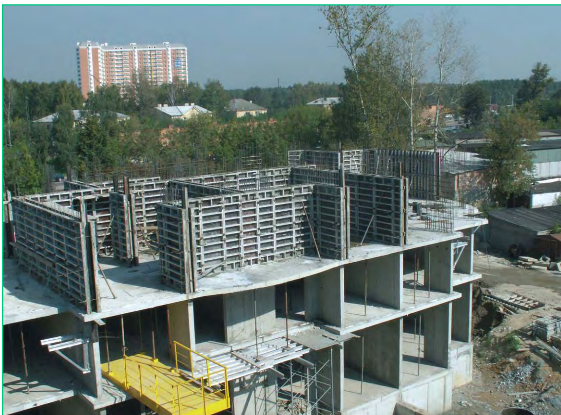
Возведение жилого дома в г. Железнодорожный Московской обл.
